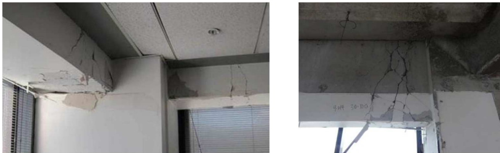
Fig.2.1 Casi di danneggiamento agli elementi strutturali. (Pampanin 2012).
