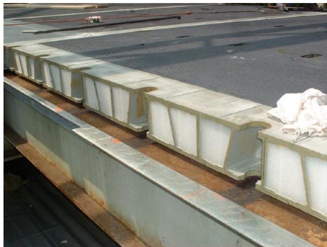
Figura 1.5.b. Particolare impalcato, Rocks Steel Truss Bridge , Maryland, U.S.A.
