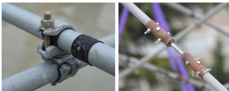
Figura 1.10. Connessioni della provvisoria Cattedrale di Creteil, Parigi, Francia.
