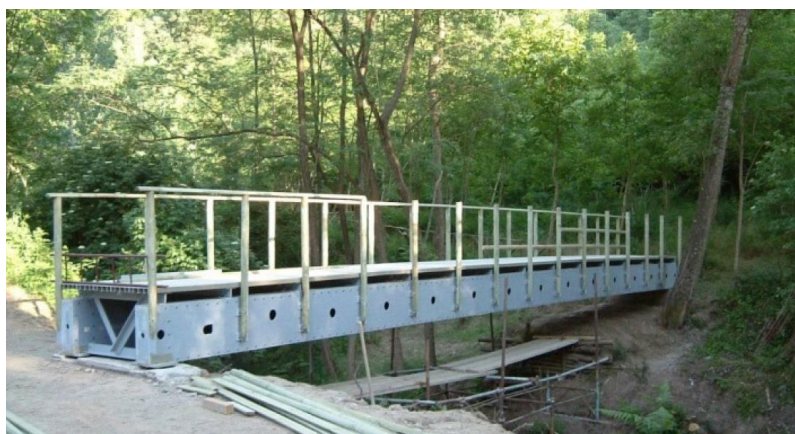
Figura 1.6. Passerella pedonale in GFRP, Grosseto, Italia.
