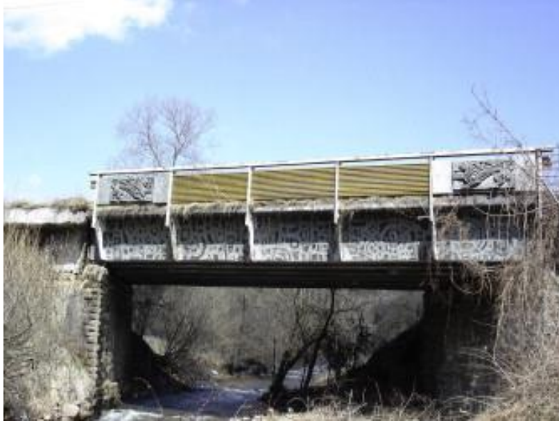
Figura 1.2. Primo ponte realizzato in GRFP a Ginzi, Bulgaria.
