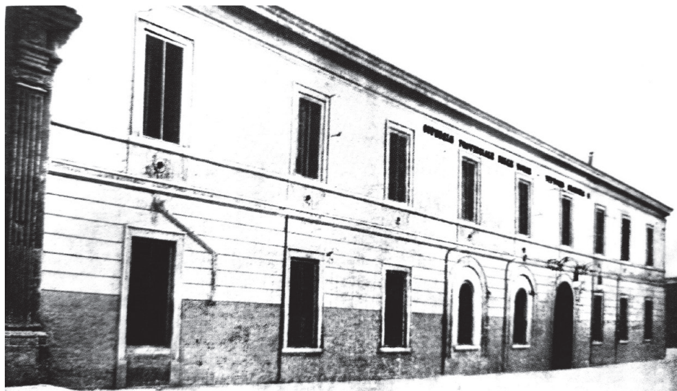
Fig. 1. Ospedale Provinciale delle donne di Foggia (Vecchi Ospedale Maternità, 1975) attuale sede del Dipartimento Studi Umanistici dell'Università di Foggia sito in Via Arpi n° 155
